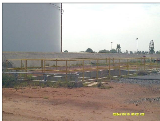
รูปที่ 2.2-8 ระบบแยกน้ำ-น้ำมัน (Oil Separator)
