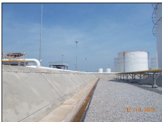
รูปที่ 2.2-26 คันคอนกรีตรอบถังเก็บน้ำมัน
