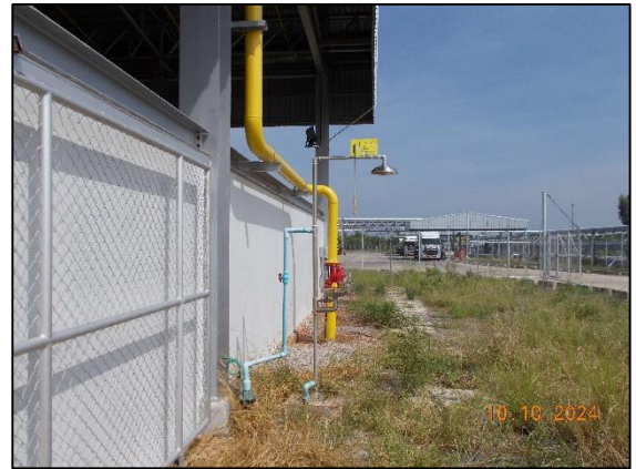
รูปที่ 2.2-24 จุดชำระล้างฉุกเฉิน (Emergency eye washer and shower)
