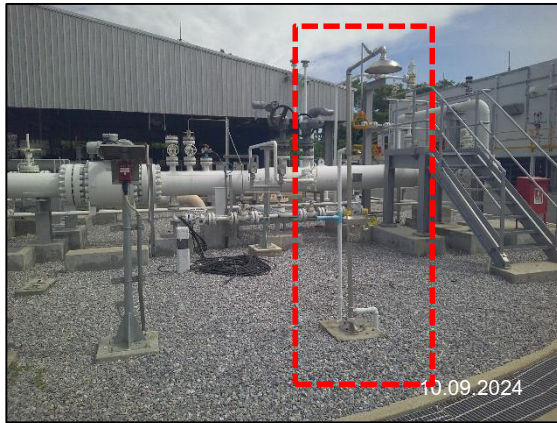
รูปที่ 2.2-24 จุดชำระล้างฉุกเฉิน (Emergency eye washer and shower)
