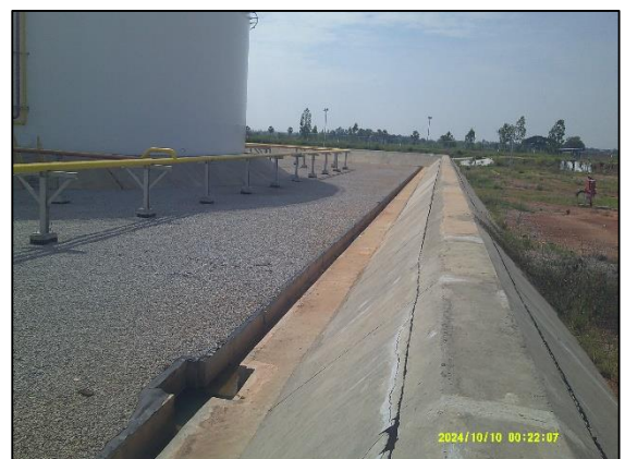
รูปที่ 2.2-26 คันคอนกรีตรอบถังเก็บน้ำมัน
